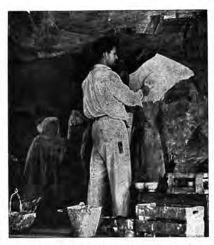
El albañil colocando el revestimiento de cal y arena sobre cuya superficie, hasta el momento antes de fraguar el pintor realiza, con colores minerales diluídos en agua, el tema proyectado previamente en los "cartones".
