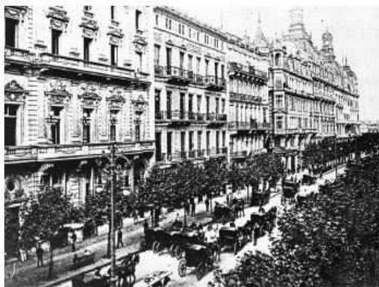
La Avenida de Mayo, primer boulevard de la Ciudad de Buenos Aires. A la izquierda, los edificios del Club del Progreso, de La Prensa y la Municipalidad. Al final de la avenida, se ve la Casa Rosada (ca. 1905).
